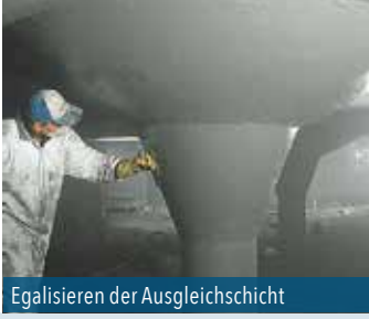
Spritzapplikation der Ausgleichschicht
