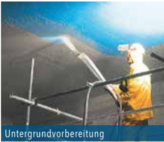
Spritzapplikation der Deckschicht
