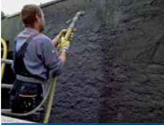
Spritzapplikation der Ausgleichschicht
