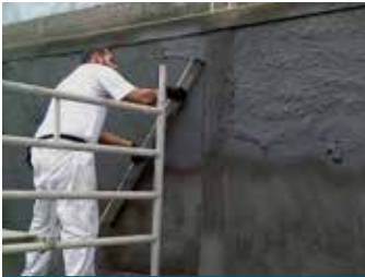
Egalisieren der Ausgleichschicht
