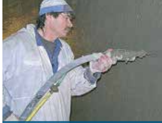
Spritzapplikation der Deckschicht
